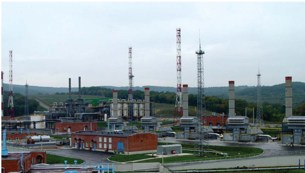
КОМПРЕССОРНАЯ СТАНЦИЯ «КРАСНОДАРСКАЯ» – ОДИН ИЗ ОБЪЕКТОВ ГАЗОПРОВОДА «РОССИЯ – ТУРЦИЯ» («ГОЛУБОЙ ПОТОК»).
